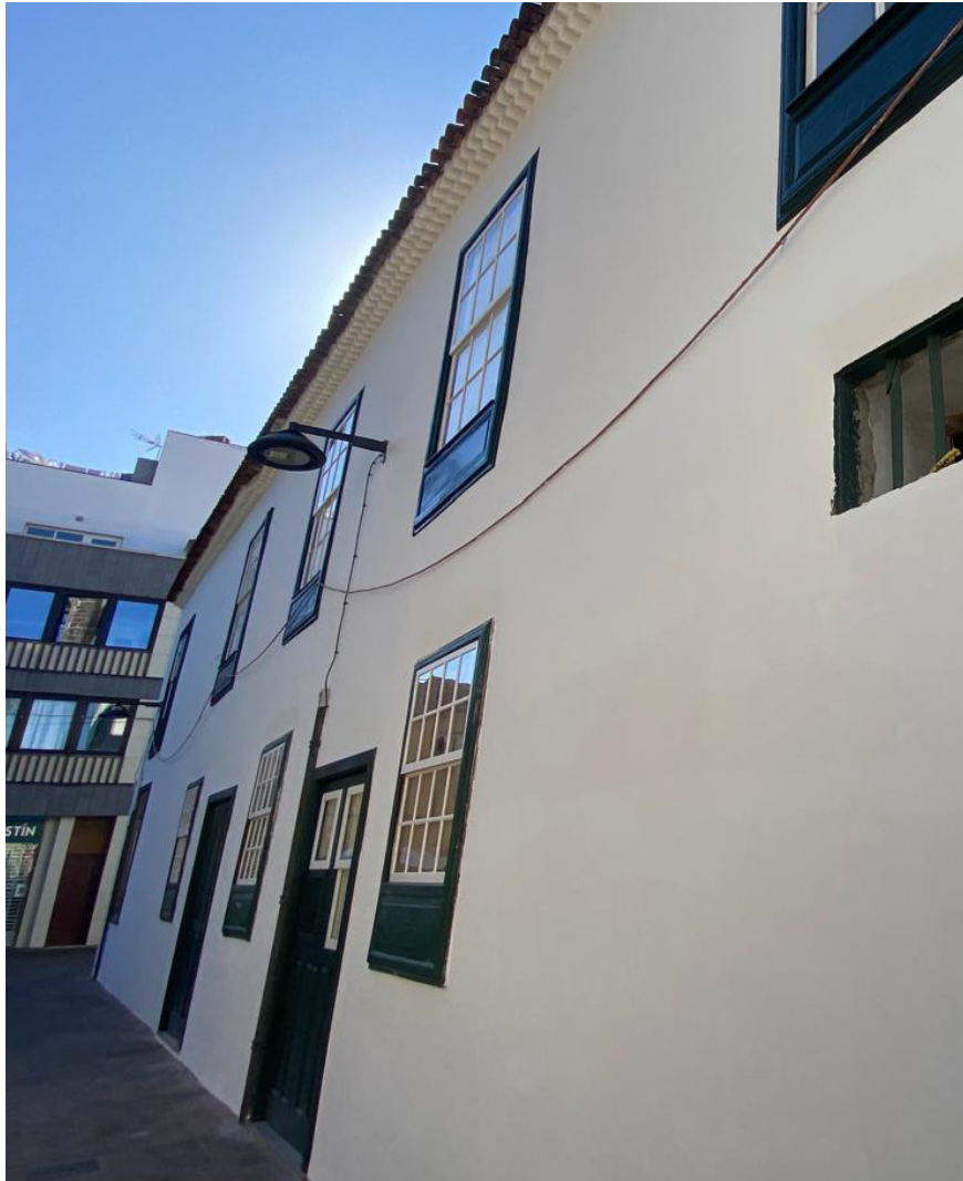
Ilustración 18 a 29. Imágenes de los avances en la reforma a finales de 2024
