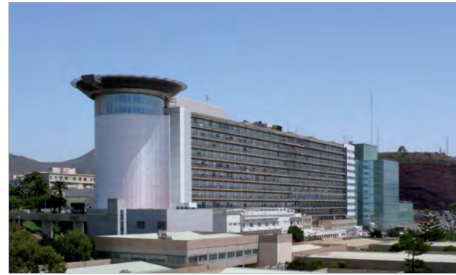
2012 Hospital Universitario de Canarias.
